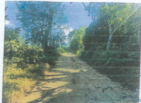
โครงการปรับปรุงถนนลูกรังสายสวนป่าส้มเชิงแสน - บ้านนาขม หมู่ที่ ๔
