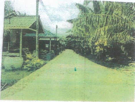
โครงการก่อสร้างถนนคอนกรีตเสริมเหล็กสายช่อวาเลนไทน์ หมู่ที่ ๗
