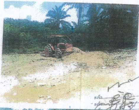
โครงการปรับปรุงอ่างกั้นขยะมูลฝอย หมู่ที่ ๒
