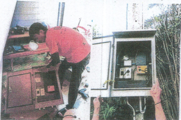
โครงการจัดซื้อกล่องโทรทัศนวงจรปิดชนิดเครือข่ายแบบมอดูมคงที่พร้อมติดตั้ง หมู่ที่ ๓
