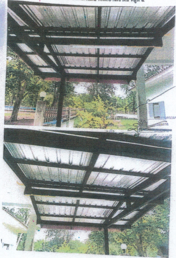
โครงการต่อเติมหลังคาทางเดิน สหค.บ้านเขาคิน หมู่ที่ ๔
