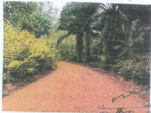
โครงการปรับปรุงถนนลูกรังสายคลองหมีมั่ง - อ่าวสำเหน หมู่ที่ ๔
