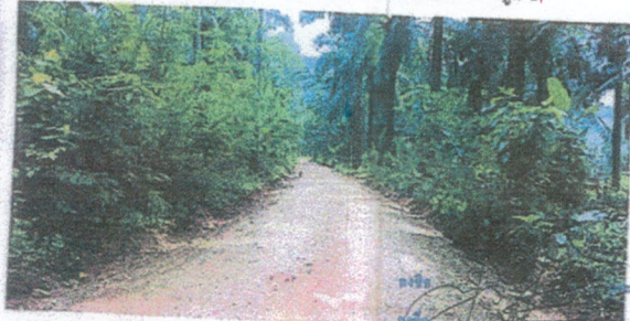
โครงการปรับปรุงถนนลูกรังสายห้วยน้ำแก้ว-คลองคว้น หมู่ที่ ๖
